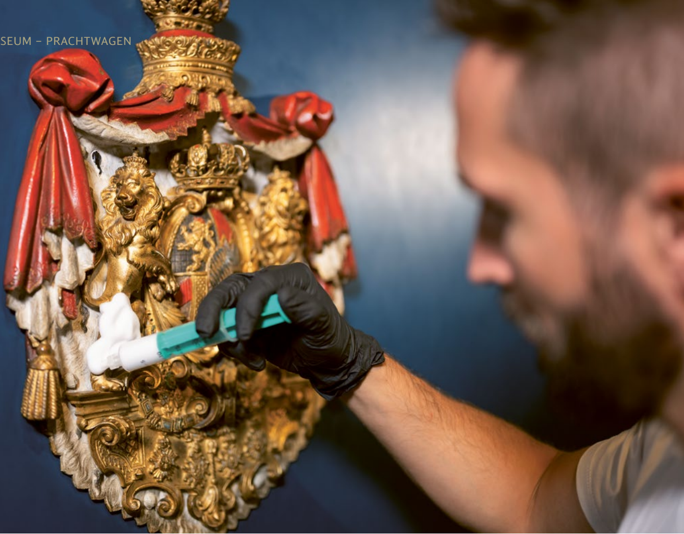
Moritz Geissmann trägt den Tensidschaum auf ein vergoldetes Ornament auf - hier das königliche Wappen außen auf der Seitenwand des Salonwagens.
